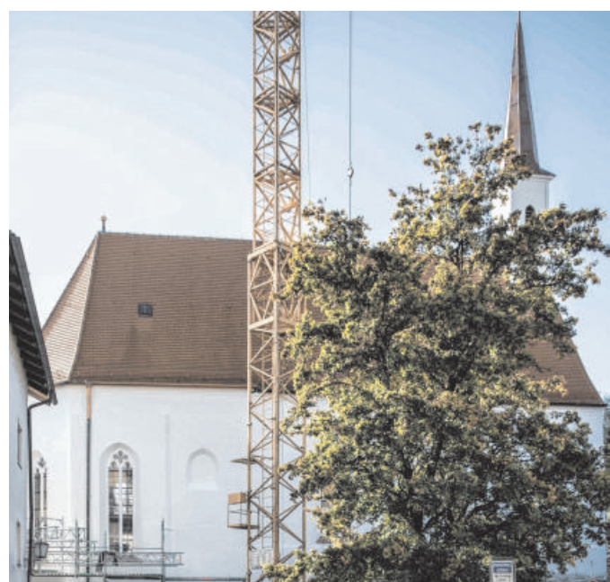
Das Gerüst ist weg: Die Katharinenkirche erstrahlt wieder im alten Glanz. FOTO KUNZMANN
